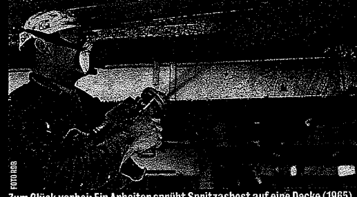
Zum Glück vorbei: Ein Arbeiter sprüht Spritzasbest auf eine Decke (1965).
